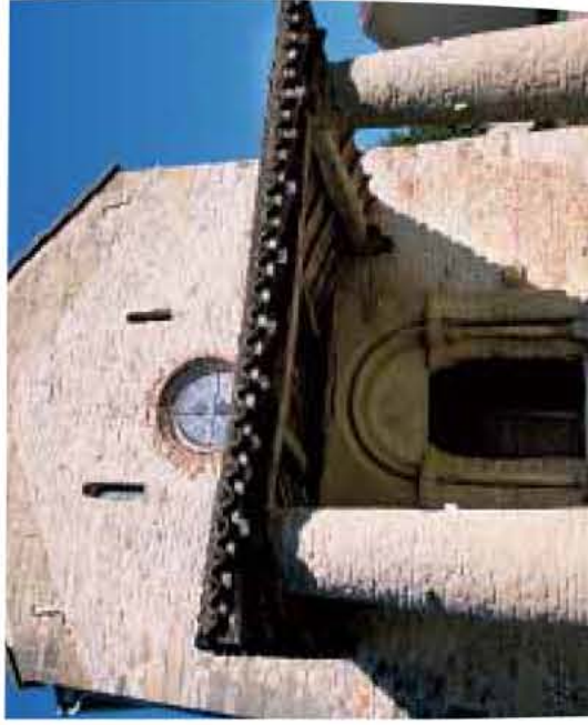
L'église de Saint-Jean-sur-Reyssouze possède un auvent (porche à galonnière) remarquable datant du XIe. Celui-ci est soutenu par des piliers dits "pattes d'éléphant". A l'intérieur de l'église dans la chapelle nord, on peut noter deux curieuses têtes humaines sculptées.
